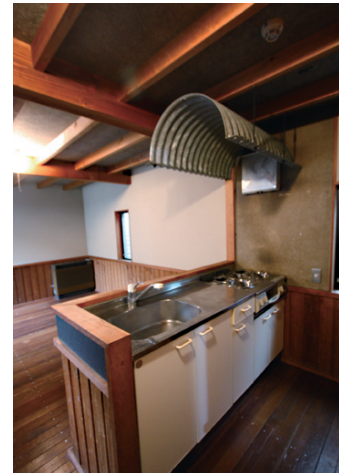
対面式キッチン。フードはコルゲート管を利用しており、元からある穴を活かして調理器具を掛けられる
